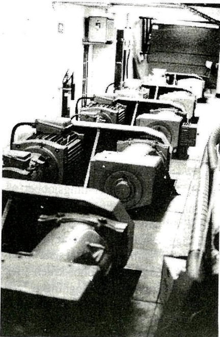
De roterande 60 Hz-omformarna.
